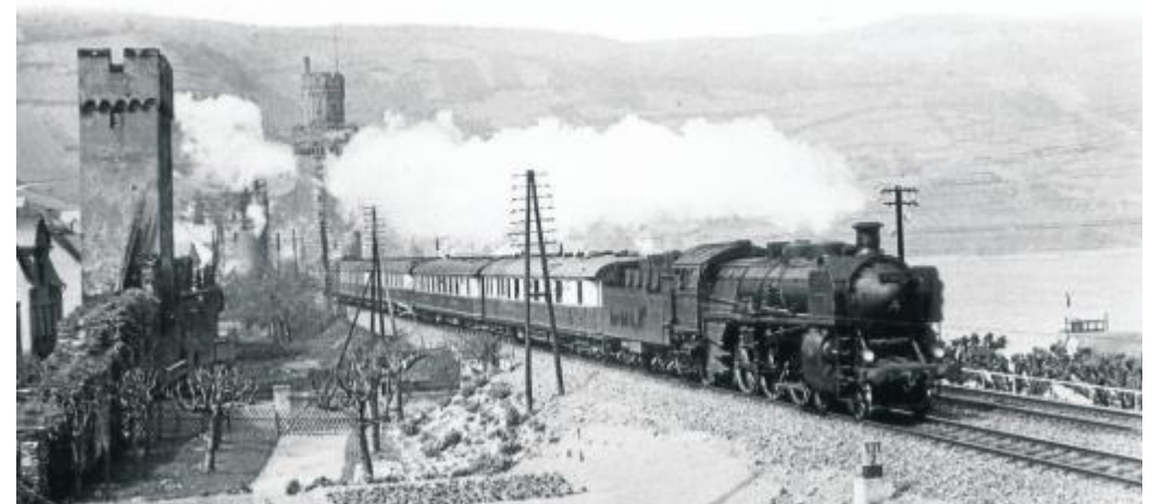
Der original „Rheingold“-Zug passiert um 1930 den Ochsenturm bei Oberwesel.
